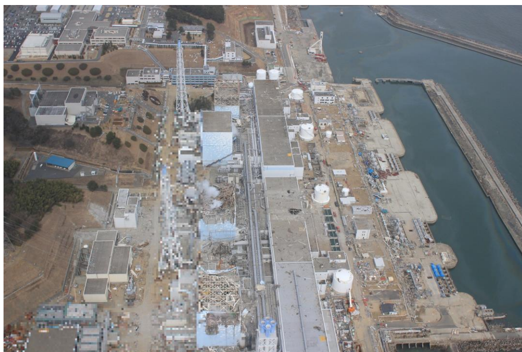
図 4.1.7 事故後の1～4号機の俯瞰撮影(2011年3月20日)
