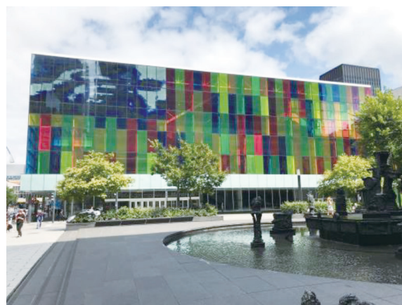
図1 カラフルな外観のモントリオール国際会議場
