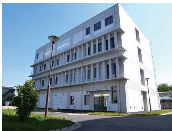
写真3 高度被ばく医療線量評価棟の外観
